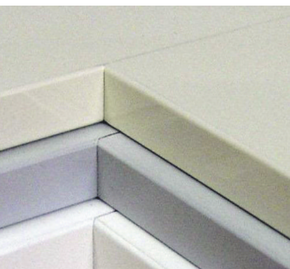
Bild 1: Saubere Sache: Auf Gehrung gearbeitete Innenecken
